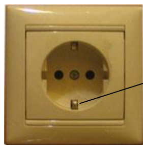
Рис. 3.5. Настенная розетка с контактом заземления.
